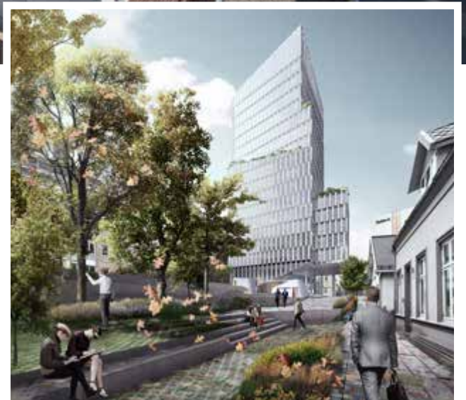
Slik ser høyhuset ut etter å ha blitt kuttet fra 26 til snaut 20 etasjer. I tillegg har det blant annet kommet til en utkraging på bygningens østside, ut over Knud Holms gate.
